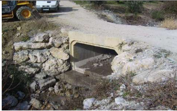
Seuil sur ouvrage amont
