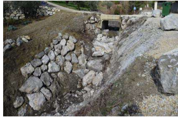
Février 2011 Protection du seuil par enrochement
