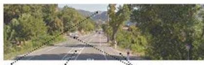
Vue Large chaussée et grande linéarité Nombreux Accès pour les différents quartiers de Buis
