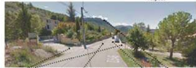
Nombreux accès aux maisons, Chaussée plus large Pente, Absence de signalisation, Vue sur le Rocher St Julien
