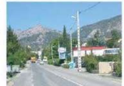
A l'approche du centre-ville, l'entrée de ville conserve son aspect routier avec d'importantes surlargeurs non traitées
