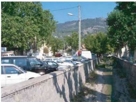
Les ouvrages d'endiguement de la crue de l'Ouvèze qui jouent leurs rôles durant les pluies cévenoles
