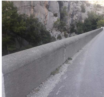
Muret Type Plot béton
