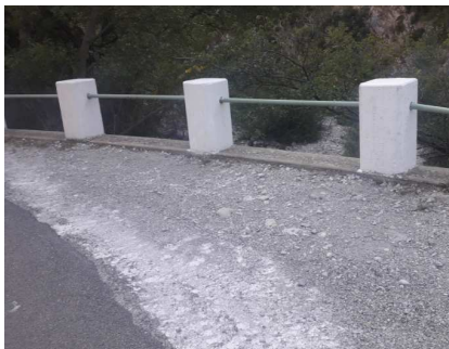
Muret Type Plot béton
